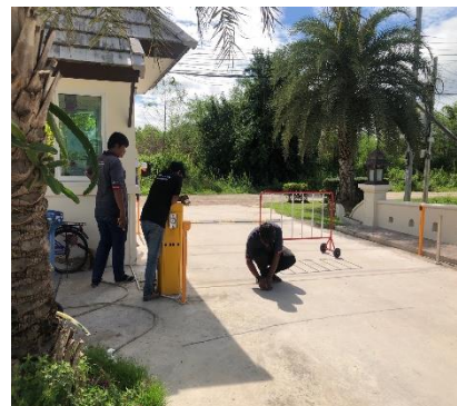
4. Replacement a new motor, barrier and install a Loop detector system for automatic boom gate เปลี่ยนมอเตอร์ และไม้กั้นใหม่ และติดตั้งระบบ Loop Detector ไม้กั้นอัตโนมัติเพิ่มเติม
