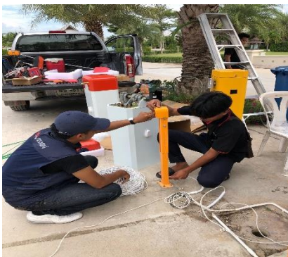
4. Replacement a new motor, barrier and install a Loop detector system for automatic boom gate เปลี่ยนมอเตอร์ และไม้กั้นใหม่ และติดตั้งระบบ Loop Detector ไม้กั้นอัตโนมัติเพิ่มเติม
